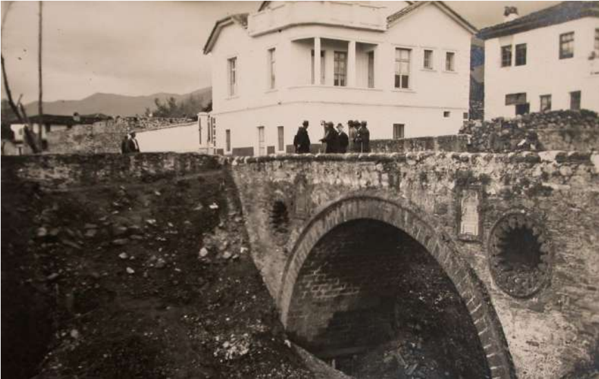
1938'lerde Postane Önünde Çarşıya Girişteki Köprü, Arka Planda Ziraat Bankası İnşaatı
